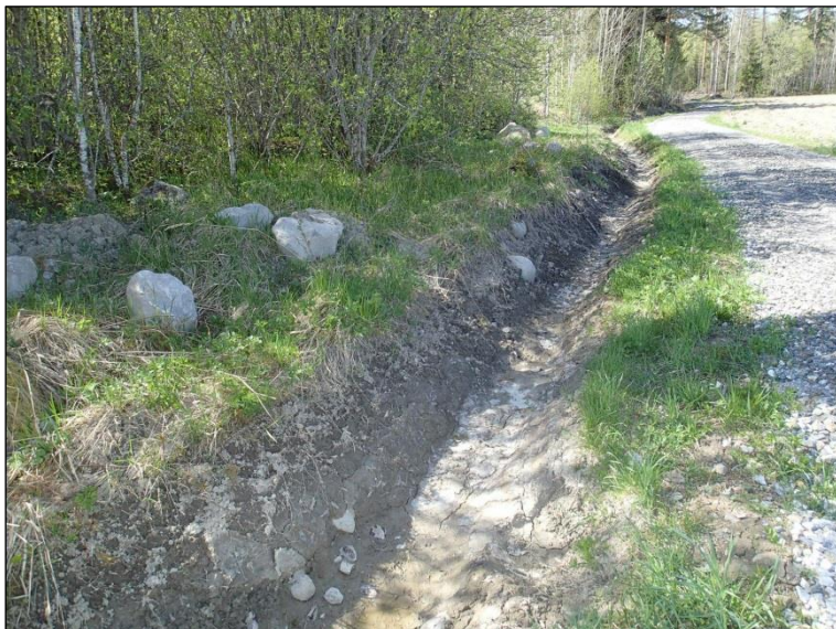
Avointa maantieojan leikkauksessa Vihasjärvellä Hulponojan eteläpuolella.
